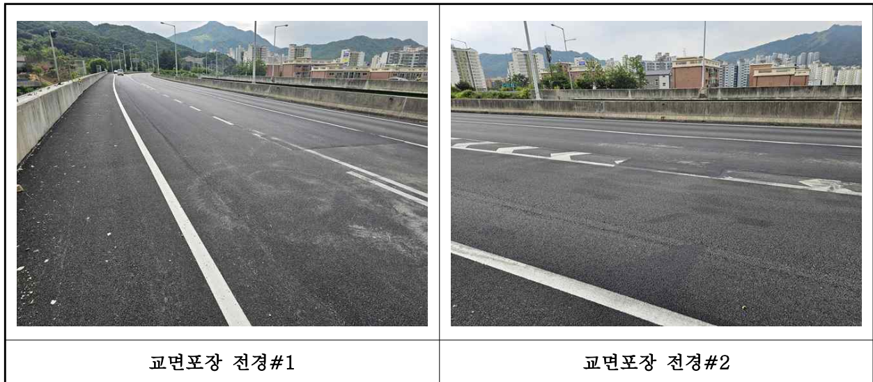
【사진 1.3.19】 교면포장 전경
