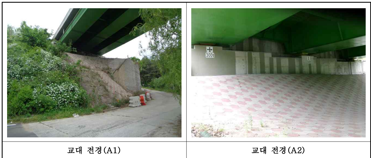
【사진 1.3.8】 교대 전경
