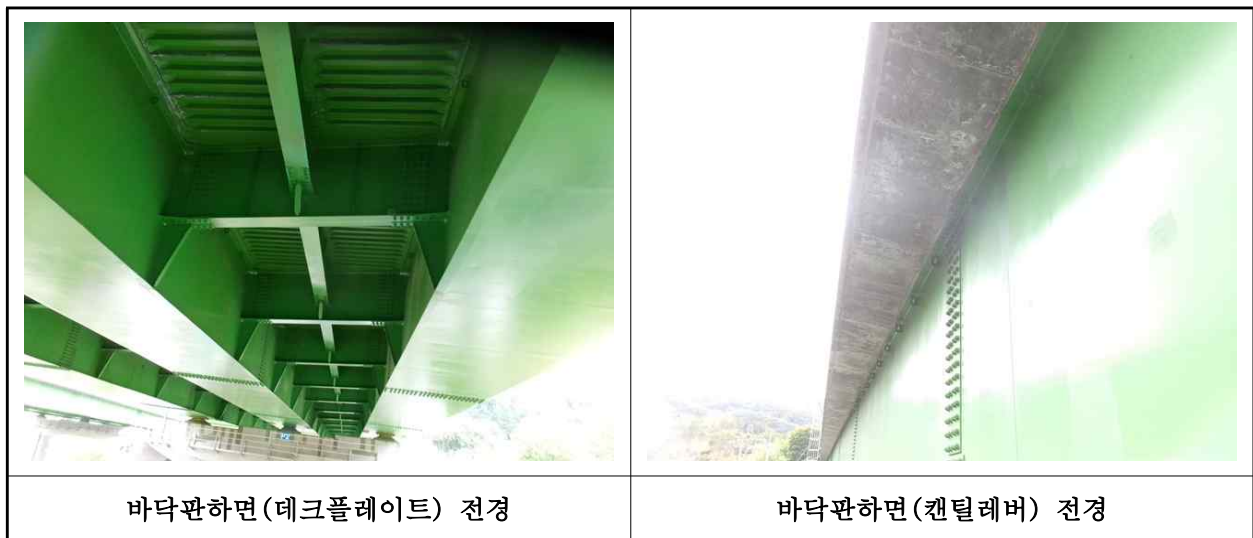
【사진 1.3.2】 바닥판하면 전경
