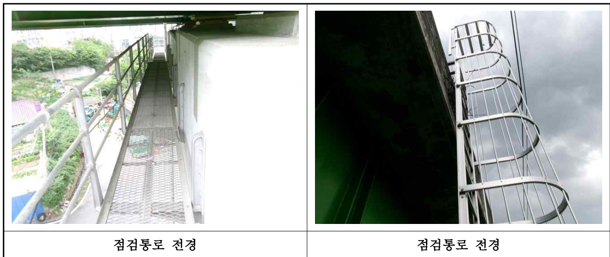
【사진 1.3.25】 교량 점검시설 전경
