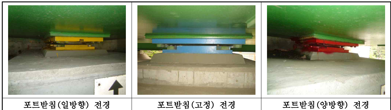
【사진 1.3.12】 교량받침 전경
