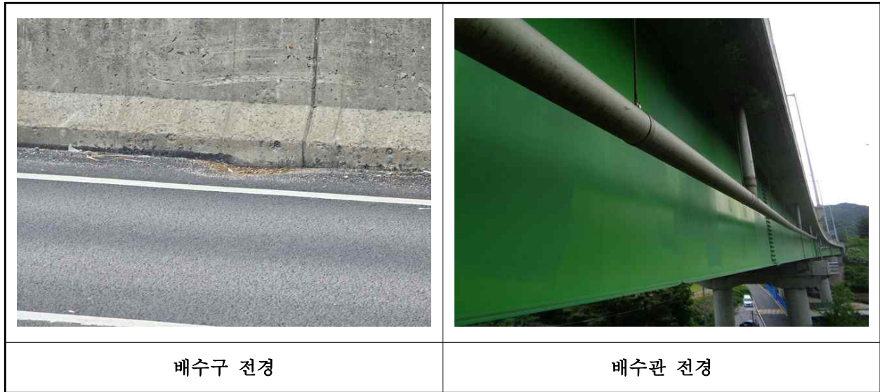
【사진 1.3.21】 배수시설 전경
